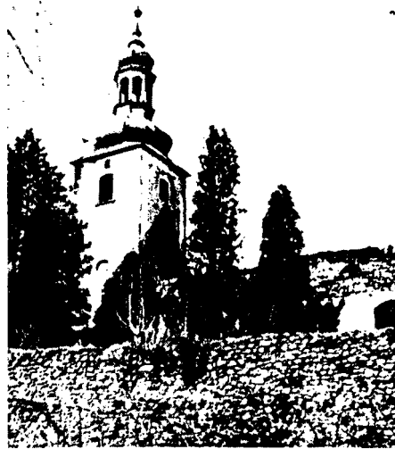
Marienkirche Neukirch a. d. Katzbach Blick über die Wehrmauer
