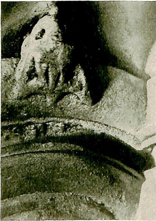
Pfeilerbasis, 1. Viertel des 13. Jahrhunderts
