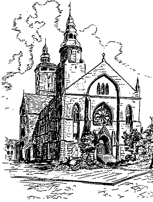
Evangelische Pfarrkirche St. Mariae vor der Erneuerung 1914/17
