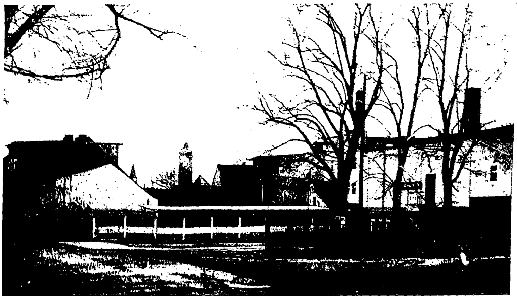
Der alte Kinosaal des Schützenhauses ist im vergangenen Sommer renoviert worden, die alte Gaststätte existiert nicht mehr.
