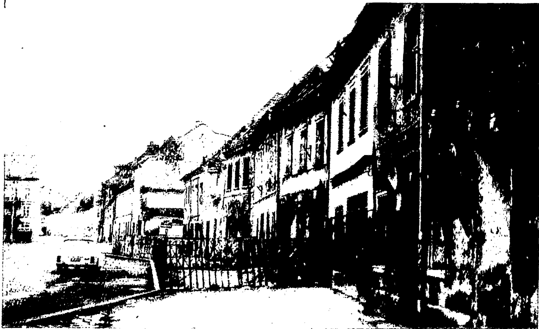
Die Ringside zwischen den Häusern von Dr. Nerger und Dr. Graeve wird abgerissen, sie muß einem Wohnblock weichen.
