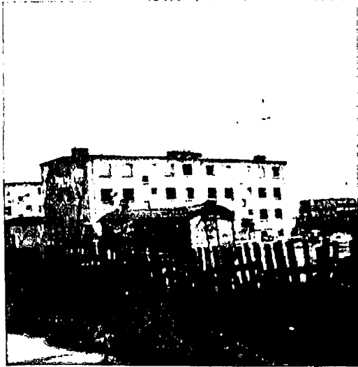
Neubauten am Bahnhof Adelsdorf 4 Bilder eing.: Günter Bleul
