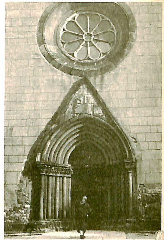
Nordwestportal der Goldberger Stadtpfarrkirche. Entnommen der Neuerscheinung „Goldberg/Schlesien — Historie, Chronik, die Kommende“ von Herrn Erich Tschirwitz. — Foto eingesandt von Herrn Erich Tschirwitz, 8600 Bamberg, Greiffenbergstr. 21
