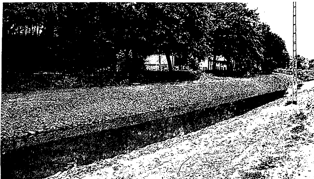
So sieht das neu eingefasste Deichsa-Ufer vom unteren Wehr bis Hainke-Brücke — wo die Aufnahme entstand — aus. — Eingesandt von Günter Bleul, 5227 Windeck-Schladern, Sonnenhang 23
