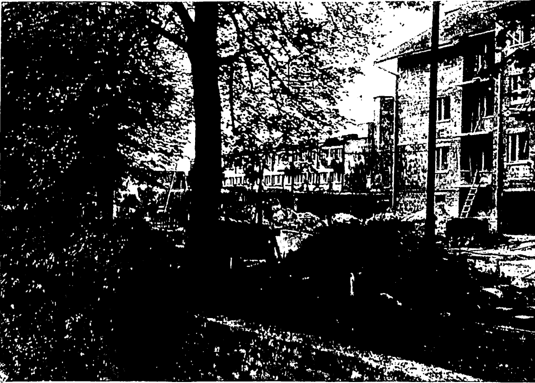
Die Katzbachstraße in Schönau wird eine Wohnstraße, denn die Schuppen, Scheunen und Garagen der Ring-Grundstücke wurden abgerissen. Die Bauarbeiten dauern zwar schon zehn Jahre, aber die ersten Wohnblöcke gegenüber von Neubarth sind schon bezogen worden. Unser Bild zeigt die Neubauten gegenüber der Neubarth-Mühle. Die Aufnahme wurde im Juni 1988 gemacht.
