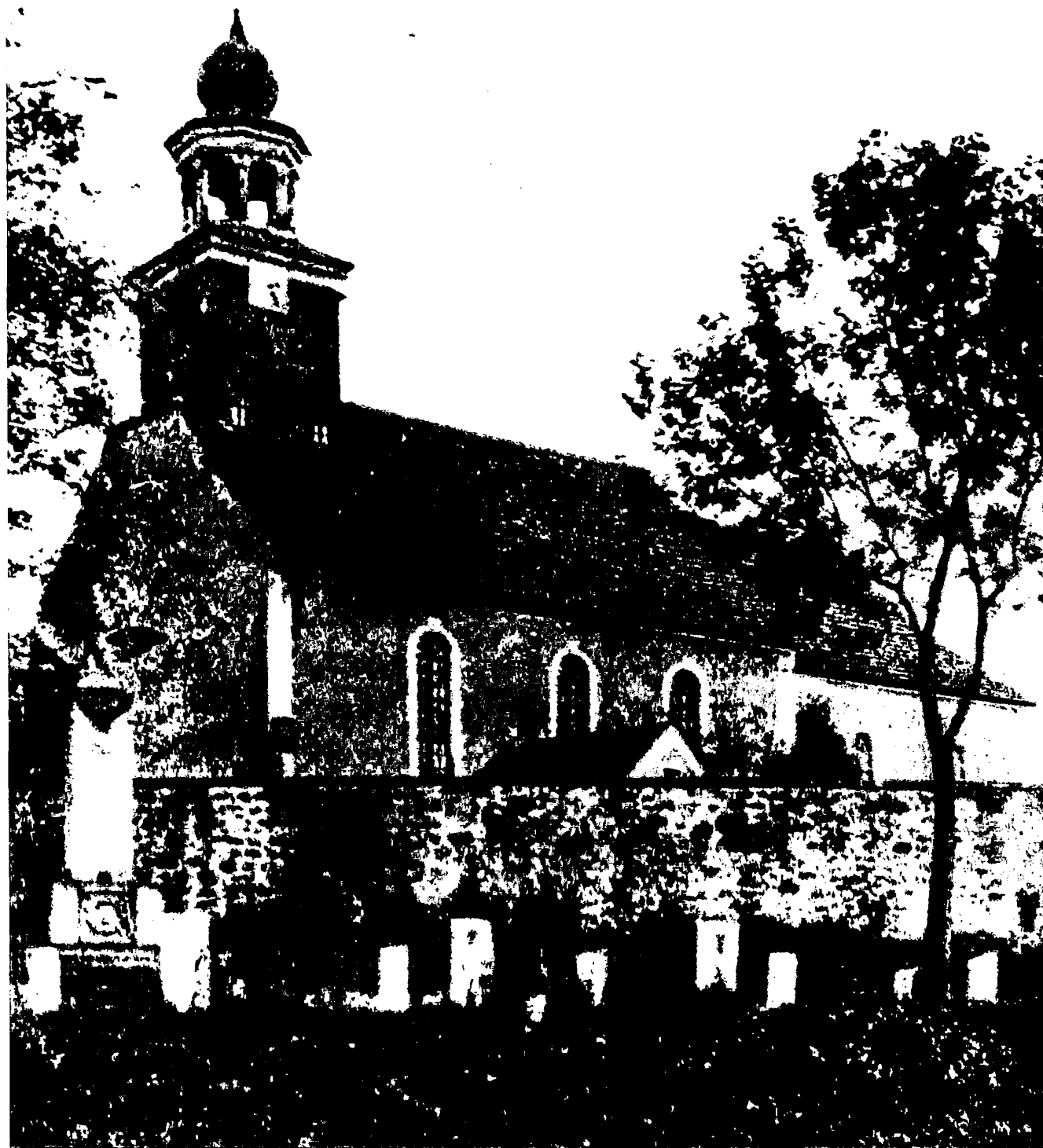
Die Kirche von Ulbersdorf mit Friedhofsmauer und Ehrenmal von 1814 bis 1918. Im Vordergrund Weidenkulturen des Dominiums am Ufer der Deichsa.
