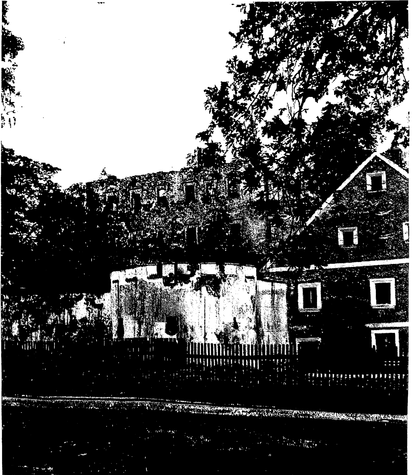
Das Alt-Schönauer Schloß ist heute nur noch eine Ruine. Es brannte 1947 aus; vermutlich wurde das Feuer absichtlich gelegt. Zuvor haben Russen und Polen das Schloß geplündert. – Dieses Foto entstand im Juni 1994.
