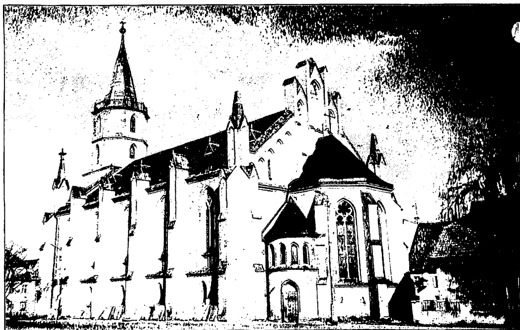
Obwohl die evangelische Kirche nicht mehr als Gotteshaus genutzt wurde, stellten die Polen sie unter Denkmalschutz und versahen sie in den achtziger Jahren mit einem neuen Farbanstrich. Da aber das Mauerwerk darunter nicht saniert wurde und die Farben schlecht waren, sah das Ergebnis der Sanierung nach einigen Jahren traurig aus, zumal für den Turm keine Farbe übrigblieb.
