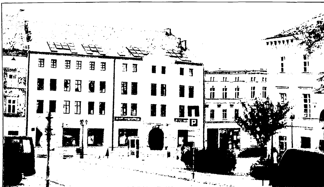
Nach jahrelanger Verschalung durch ein Baugerüst grüßt jetzt die Fassade des ehemaligen Hotels „Drei Berge“ die Besucher des Goldberger Rings. Der Neubau fügt sich gut ins Straßensbild ein.
