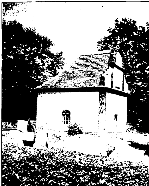
Die Begräbniskapelle des Göllschauer Friedhofes wurde restauriert und wird wieder genutzt. Bild: Walter Kunzendorf
