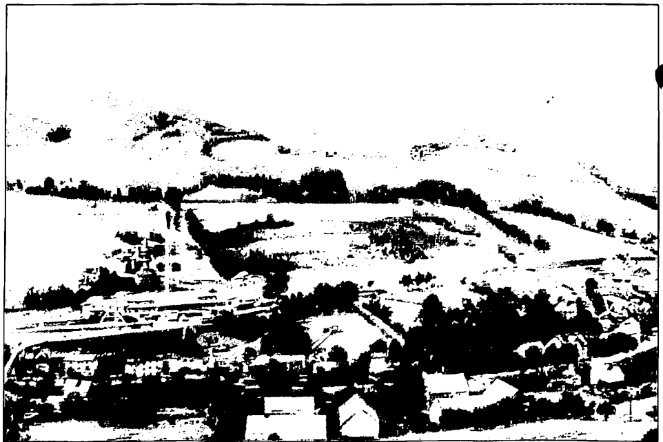
Eingang in das Katzbachtal Ober-Kauffung. Werk Elbel-Kauffung mit Elbel-Bruch. Links die Katzbach. Aufnahme von 1938.
