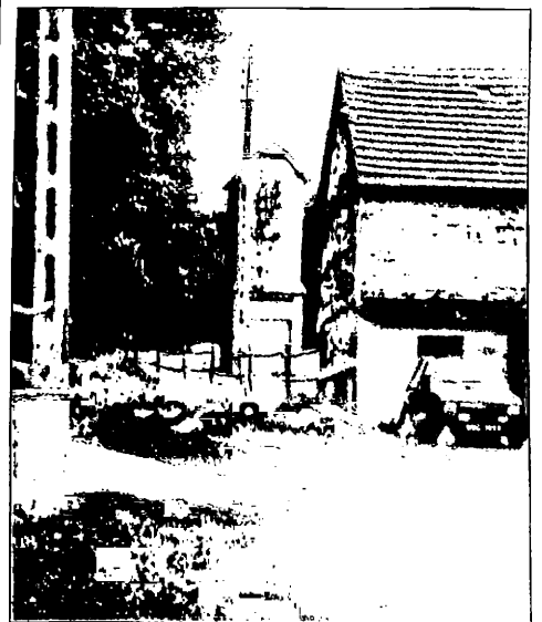
Das Bischdorfer Transformatorenhaus steht neben der Scheune von Fiebig, Nr. 107. Das Bild wurde im Jahr 2004 aufgenommen.
