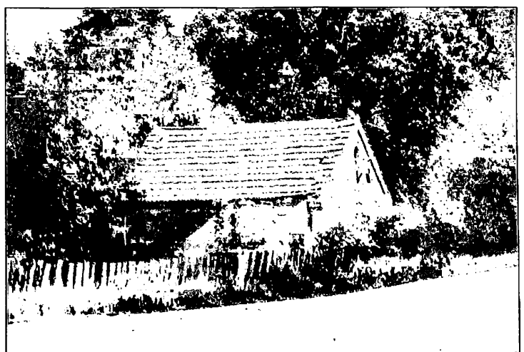
Feuerwehrhaus in Woitsdorf
