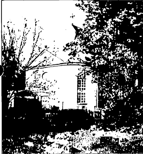
Der Eingangsbereich der ev. Kirche mit der Gruft links davor
