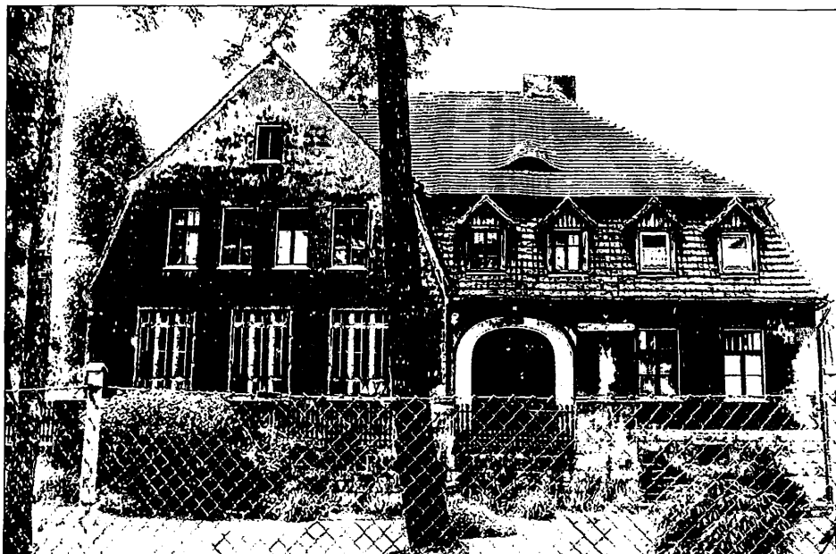
Die ehemalige Röversdorfer Schule
