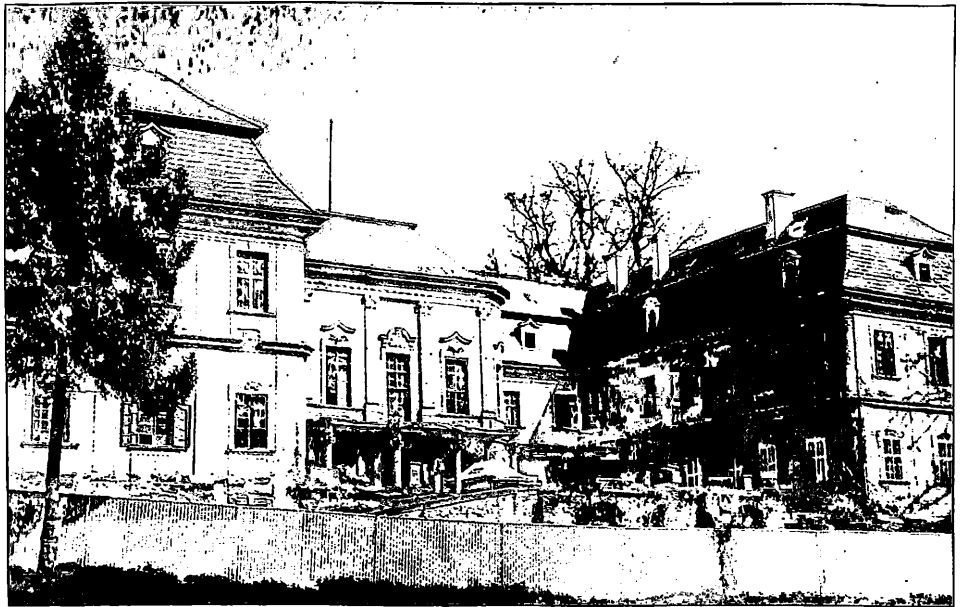
Das Schloß in Gröditzberg mit neuem Dach
